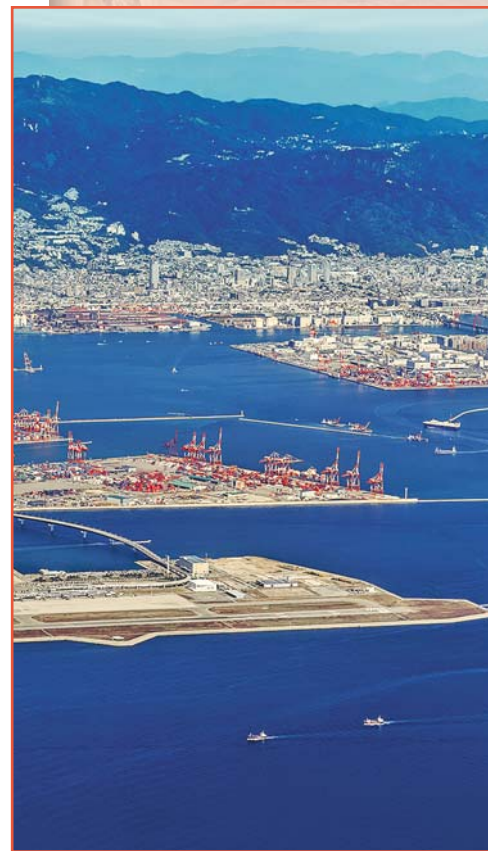
Аэропорт Кобе на насыпных землях
